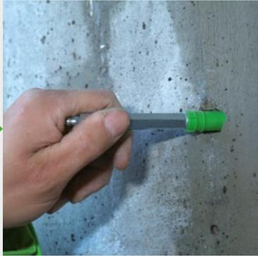
Jetzt werden die KÖSTER Superpacker in die Bohrlöcher eingesetzt, wobei etwa jedes dritte Bohrloch zunächst offen bleibt.
