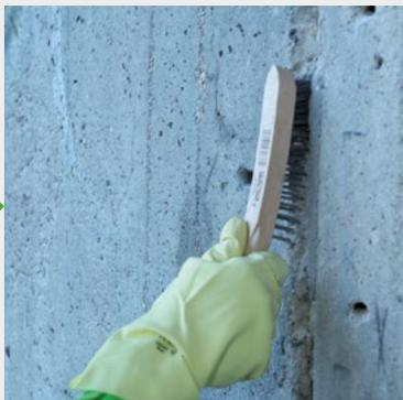
Der V-förmig geöffnete Riss wird mit einer Drahtbürste gereinigt.
