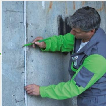
Die Positionen, an denen die Injektionspacker gesetzt werden sollen, werden markiert. Die Löcher für die Packer werden entlang des Risses auf beiden Seiten wechselseitig in Abständen von ca. 10 bis 15 cm gebohrt.
