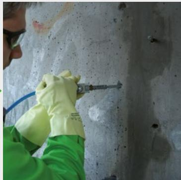
Die Injektionspeitsche wird mit dem Ventil des Injektionspackers verbunden. Dann wird das Ventil durch eine Drehung des Handhebels um 90° geöffnet. Jetzt wird das Injektionsmaterial in den Riss gepumpt. Dabei wird grundsätzlich von unten nach oben gearbeitet. KÖSTER 2 IN 1 kann mit der KÖSTER 1K-Injektionspumpe verarbeitet werden.
