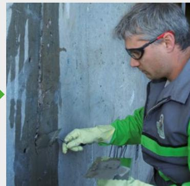
Anschließend kann der Riss z. B. mit KÖSTER KB-Fix 5 geschlossen werden. Das Verschließen des Risses verhindert, dass Injektionsmaterial vorzeitig während der Injektion aus dem Riss herausfließt. Die Verarbeitungszeit beträgt circa fünf Minuten, abhängig von der Umgebungstemperatur und der Luftfeuchtigkeit.
