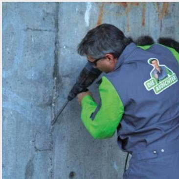
Der Riss wird an der Oberfläche in V-Form (ca. 1 bis 2 cm tief) geöffnet. Anschließend werden lose Teile und Staub mit einer Bürste entfernt.
