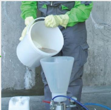
Die Injektionspumpe wird entsprechend der Bedienungsanleitung vorbereitet. Anschließend kann das fertig gemischte Harz in den Materialbehälter der Pumpe gefüllt werden. Das angemischte Material muss innerhalb der Topfzeit verbraucht werden.
