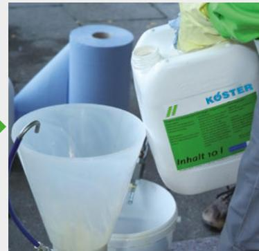
Die Pumpe wird mithilfe des KÖSTER PUR Reinigers entsprechend der Bedienungsanleitung der Injektionspumpe gereinigt. Nachdem das Harz ausreagiert ist, werden die Injektionspacker entfernt und die Bohrlöcher mit einem Mörtel verschlossen. Dazu eignet sich zum Beispiel KÖSTER KB-Fix 5.
